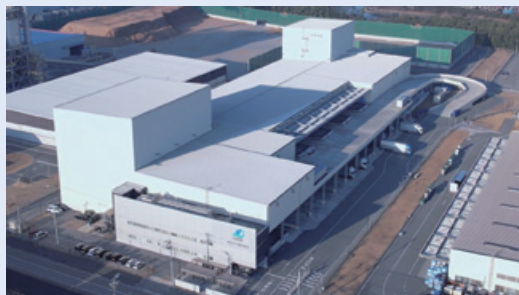
MDロジス 広畑グローバルロジスティクスセンター
