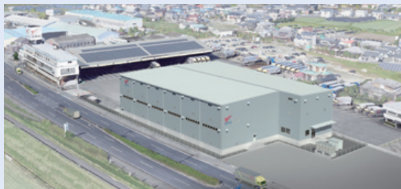
関東西濃運輸 高崎物流センター
